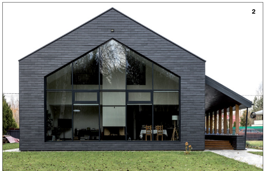
Del Carmen fassaad
