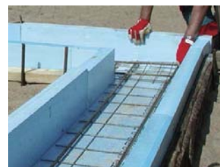
STYROFOAM plaatide paigaldus keldri seinalle polüuretaanliimiga. STYROFOAM plaatide kasutamine vundamentidialdmiku raketisena kui ka soojustusena
