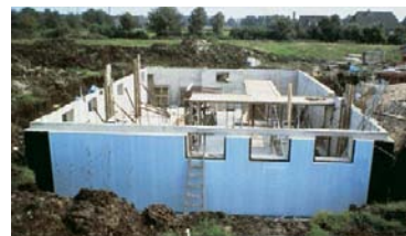
STYROFOAM 250 SL-A-N soojustusplaatide kasutamine keldriseinte soojustamisel
