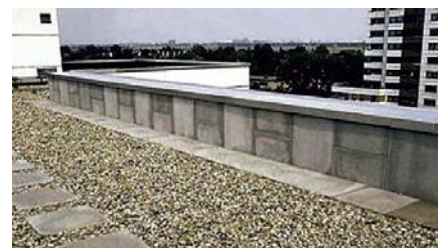
Korterimaja kruusakattega pööratud katus, käiguteed raudbetoonplaatidest, STYROFOAM 250
