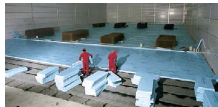
STYROFOAM 400 plaatide paigaldus külmhoones
