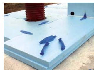
STYROFOAM 250 SL-A-N soojustusplaatide kasutamine madala lintvundamenti soojustamisel. Külmakerkekaitsesplaatide omavaheline kinnitus FOAMLOCK klambriaga.
