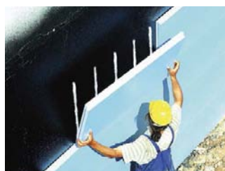
STYROFOAM plaatide paigaldus keldri seinalle polüuretaanliimiga. STYROFOAM plaatide kasutamine vundamentidialdmiku raketisena kui ka soojustusena
