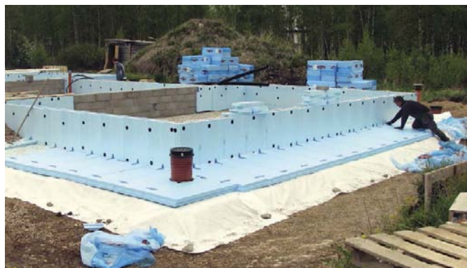
STYROFOAM 250 – eramu keldriseina, sokli, perimeetri ja põranda soojustusena
