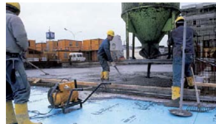
Monoliitse raudbetoonplaadiga kaetud liiklusega koormatud parkimiskatus, STYROFOAM 400/500/700
