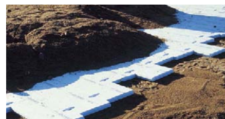
Efektiivne külmakerkekaitse raudteede ja maanteede muldkehades, STYROFOAM 500 ja 700
