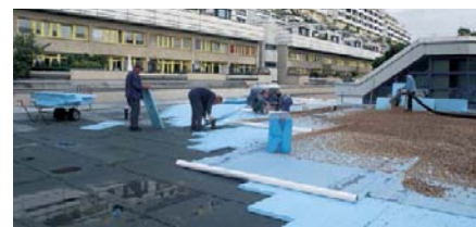
Vana katuse renoveerimine kruusakattega PLUS lahendusega, STYROFOAM 250
