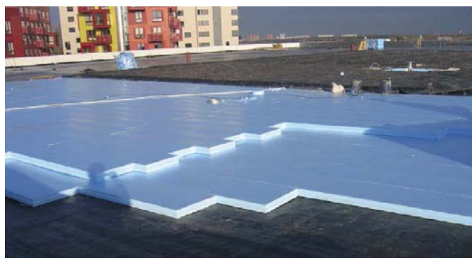
STYROFOAM 300 – soojustus pööratud parkimiskatusel, Rocca al Mare Prisma
