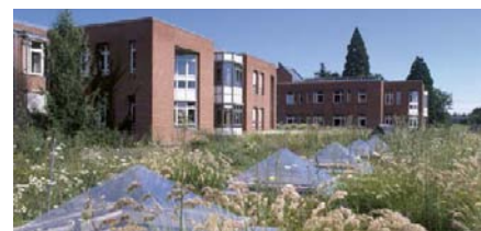
Kasvustraadiga ja taimestikuga roheline pööratud katus, STYROFOAM 300
